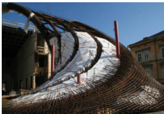
Bild 13. Bewehrungsverlegung Fig 13. Placing of reinforcement
