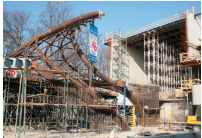
Bild 7. Teilfertige Stahlkonstruktion Fig 7. Partially finished steel structure
